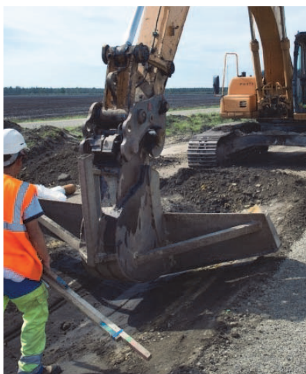
Figure 4. Gabarit spécial pour mise en forme des fossés
