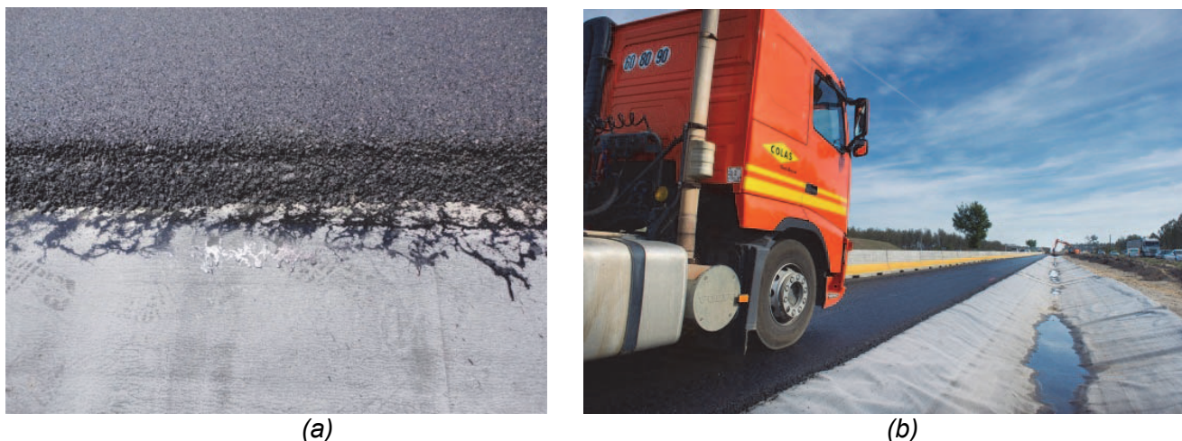
Figure 9. Couche de roulement en enrobés mise en œuvre sur la géomembrane (a), détail (b)
