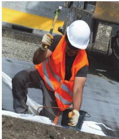
Figure 6. Ancrage par agrafes métalliques
