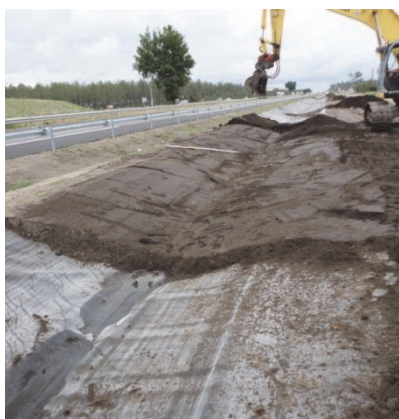
Figure 10. Mise en œuvre de la terre végétale sur la géomembrane
